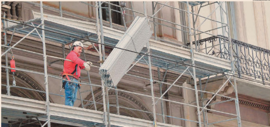
Ultimi giorni. Per ottenere il maxi sconto del 110% i lavori dovranno essere avviati entro il 25 novembre con presentazione della certificazione
