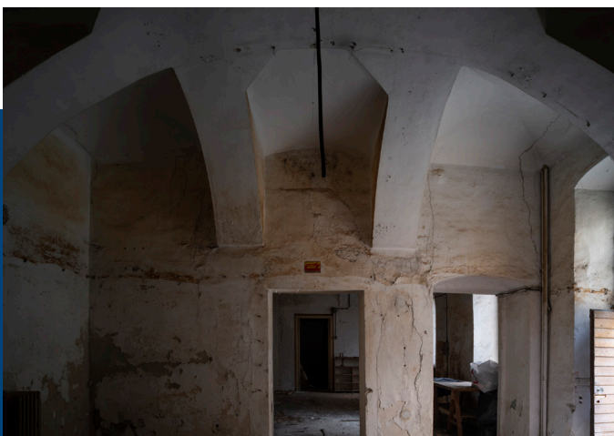
Fotografia di Fabio Oggero
