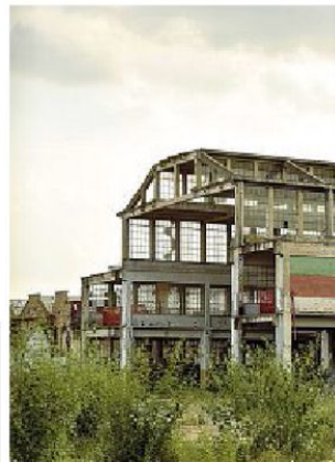
Abbandonati Un immobile ancora in disuso che si trova in corso Vercelli all'angolo con corso Vigevano
